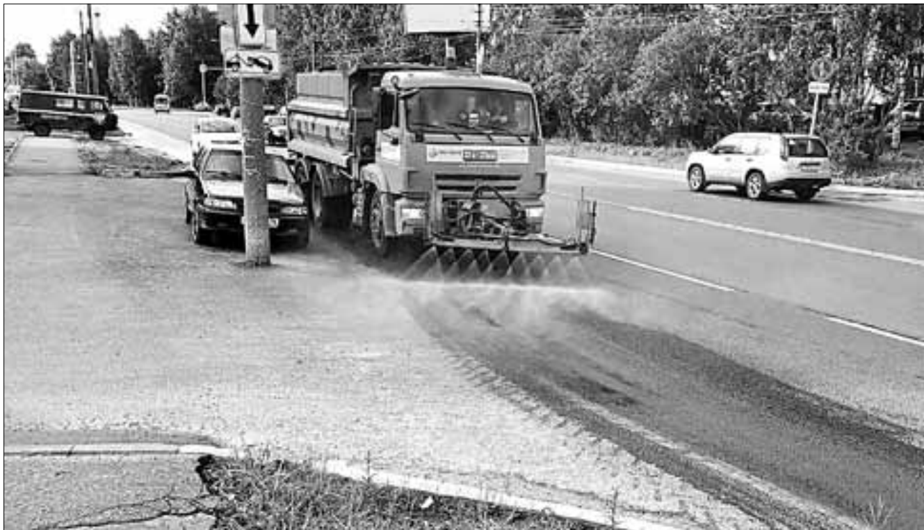
ФОТО: ПРЕСС-СЛУЖБА ПЛЕСЕЦКОГО ДОРОЖНОГО УПРАВЛЕНИЯ
