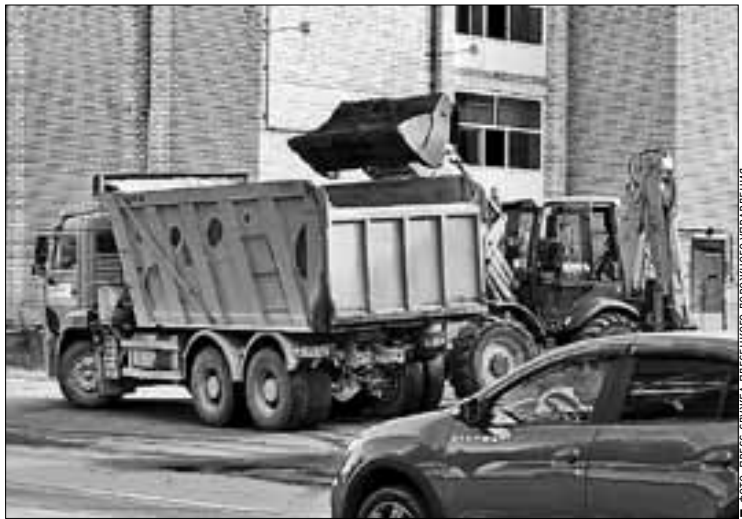
ФОТО: ПРЕСС-СЛУЖБА ПЛЕСЕЦКОГО ДОРОЖНОГО УПРАВЛЕНИЯ
